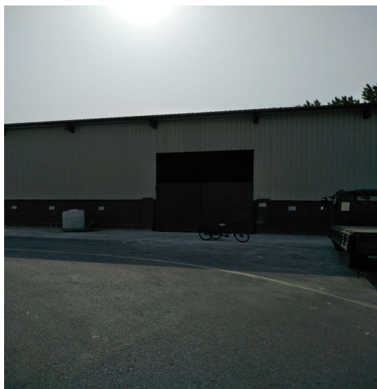
一般固废暂存处
